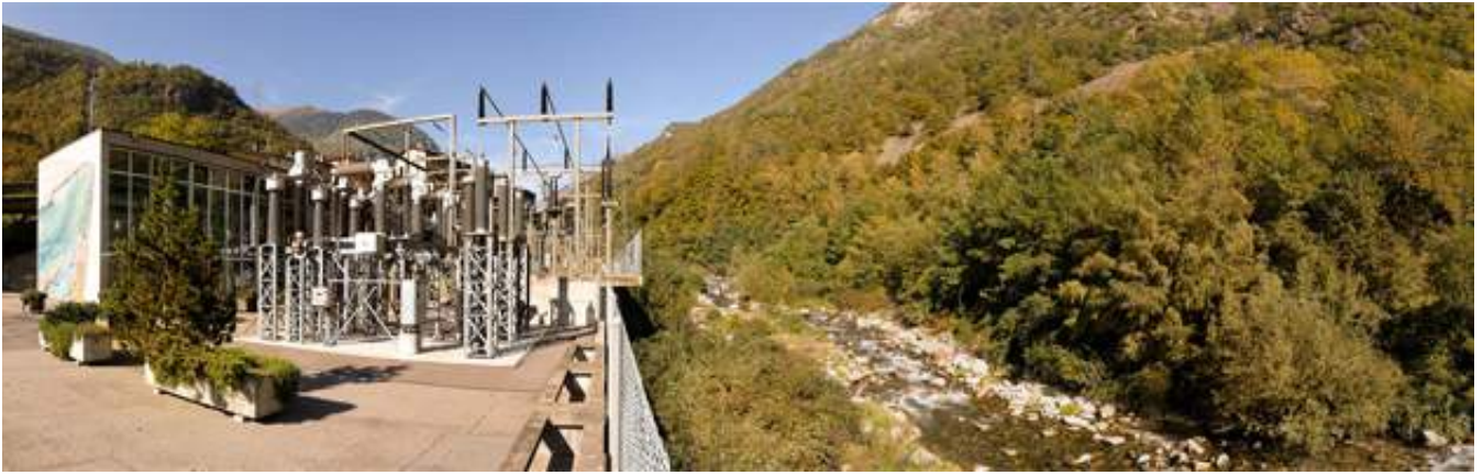
Centrale di Campocologno - Foto: REpower, www.repower.com
